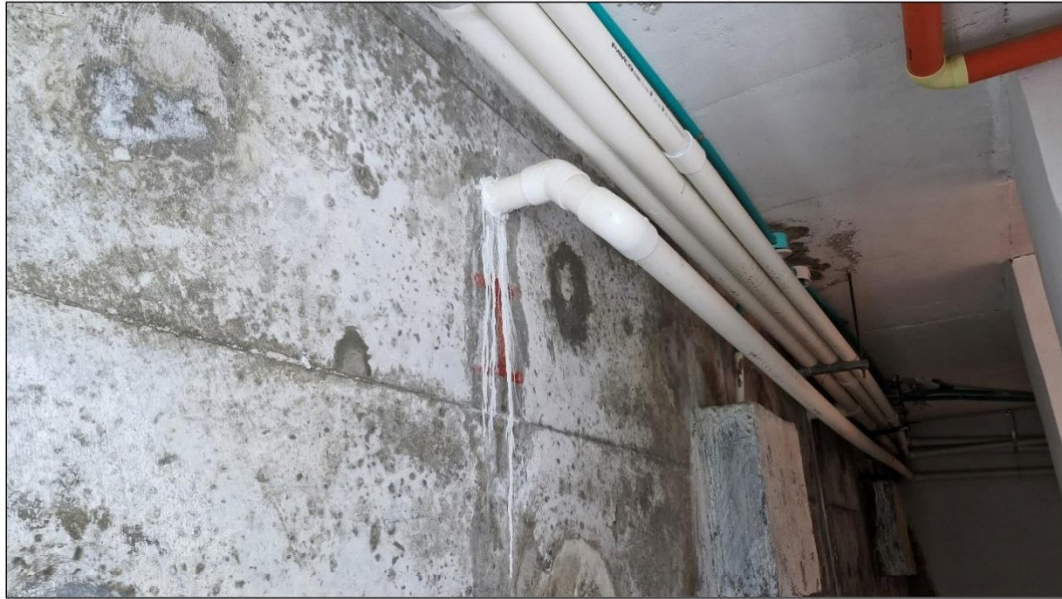
Foto 19. Filtración de agua de la piscina y formación de eflorescencias
