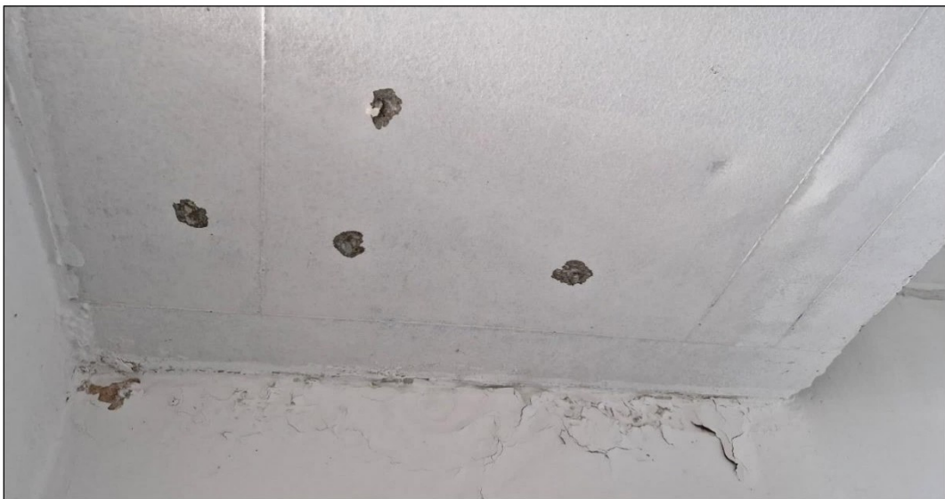
Foto 16. Presencia de pop out por posible reactividad álcali agregado en la parte baja de la piscina.
