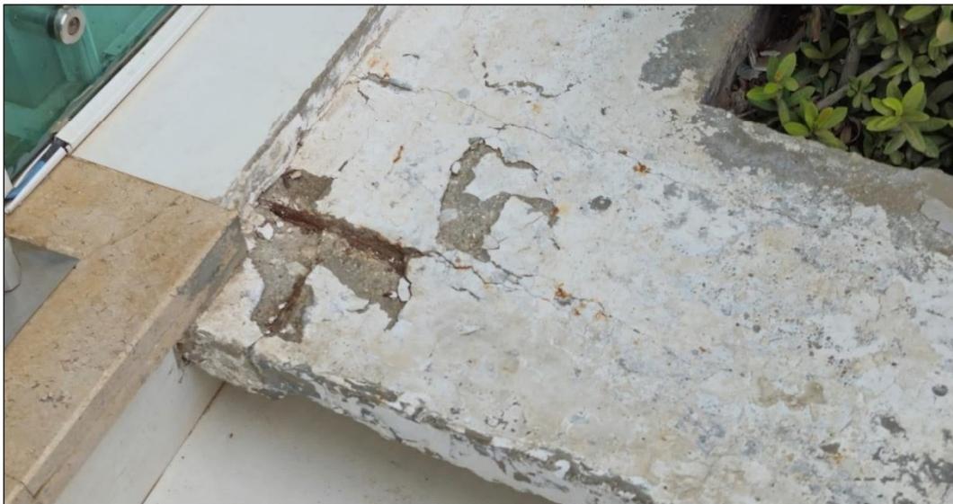
Foto 12. Corrosión del acero de refuerzo de elementos no estructurales
