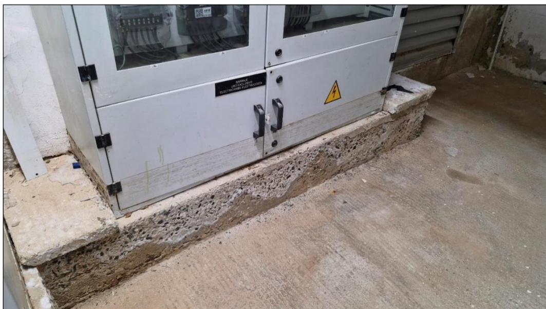
Foto 14. Deterioro superficial del concreto por posible ataque por sulfatos
