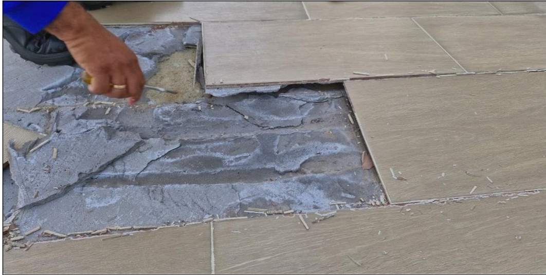
Foto 21. Desprendimiento de las baldosas de piso de la zona de la piscina.
