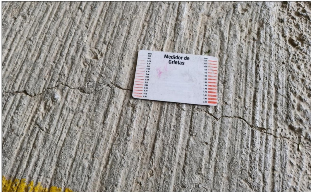
Foto 25. Fisuras en la parte superior de la losa de entepiso de parqueaderos
