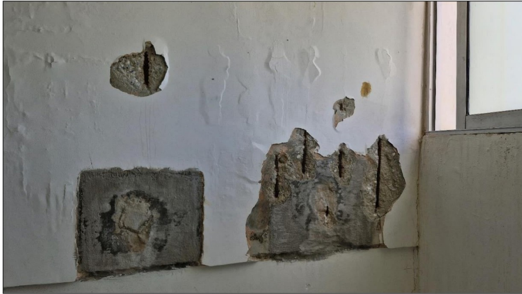
Foto 7. Corrosión del acero de refuerzo en muros estructurales en la zona de piscina.
