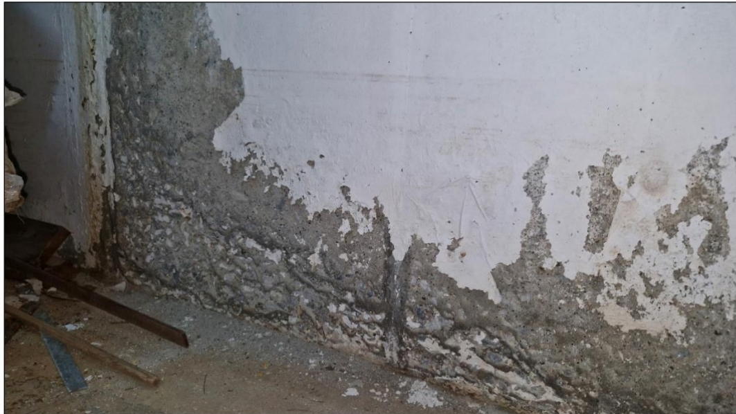
Foto 13. Deterioro superficial del concreto por posible ataque por sulfatos
