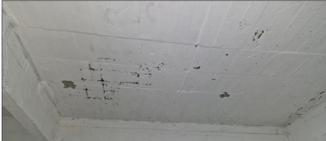
Foto 17. Mallas de acero expuestas
