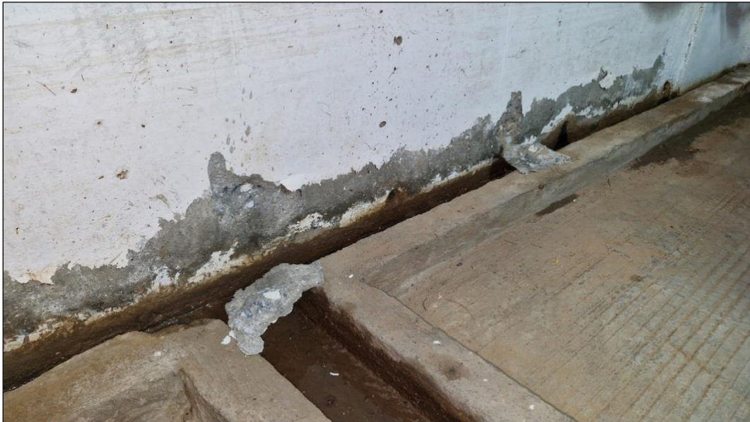
Foto 15. Deterioro superficial del concreto por posible ataque por sulfatos y presencia de pop out por posible reactividad álcali agregado
