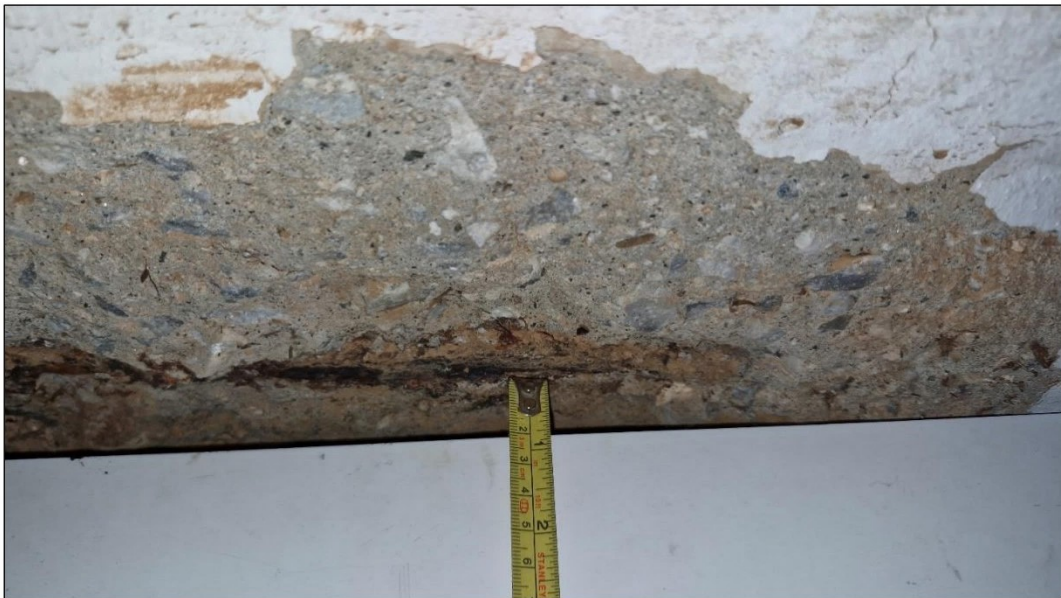
Foto 6. Corrosión del acero de refuerzo. Se observa que el recubrimiento es menor a 2 cm.
