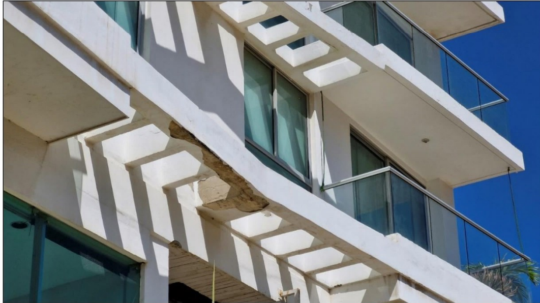
Foto 9. Corrosión del acero de refuerzo en elementos de la fachada
