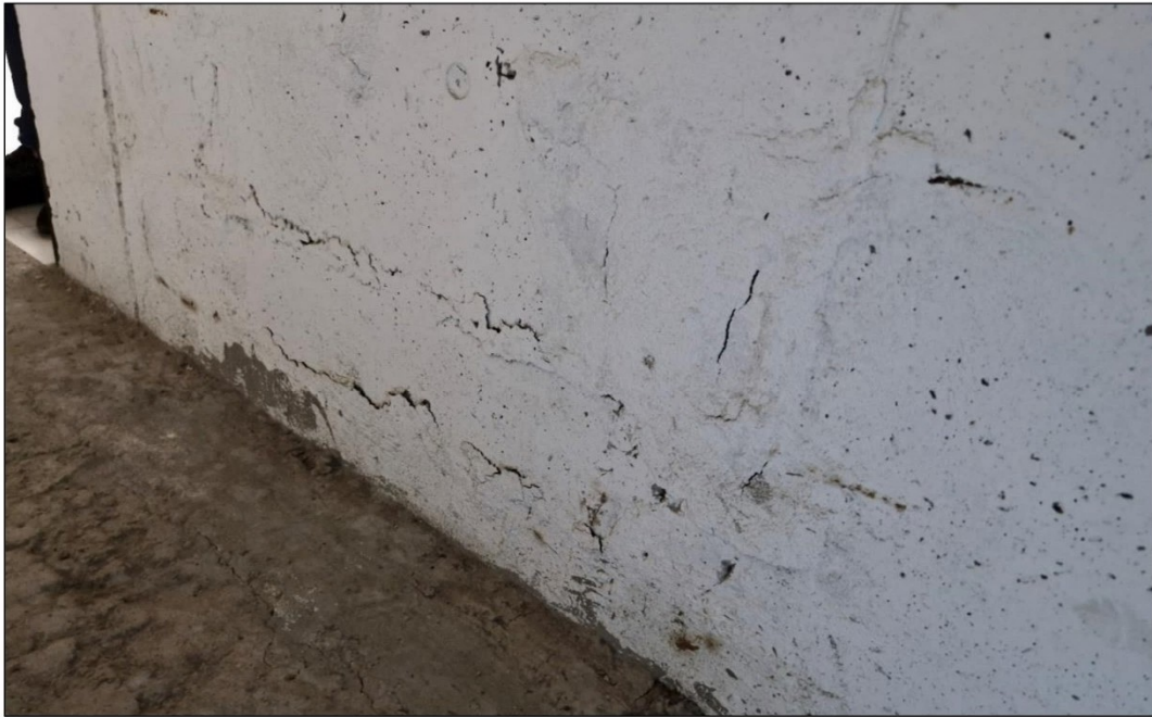
Foto 5. Fisuras y delaminaciones por corrosión en pantallas de concreto en el sótano
