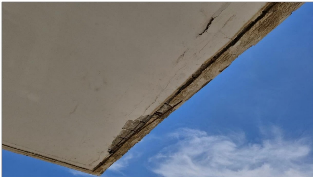
Foto 10. Corrosión del acero de refuerzo en elementos de la fachada
