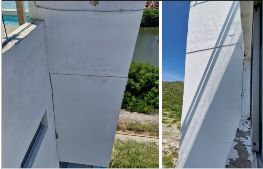
Foto 23. Movimiento de los muros en mampostería de un voladizo bajo la piscina
