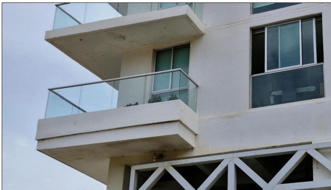
Foto 26. Deterioro de los acabados en balcones y fachadas
