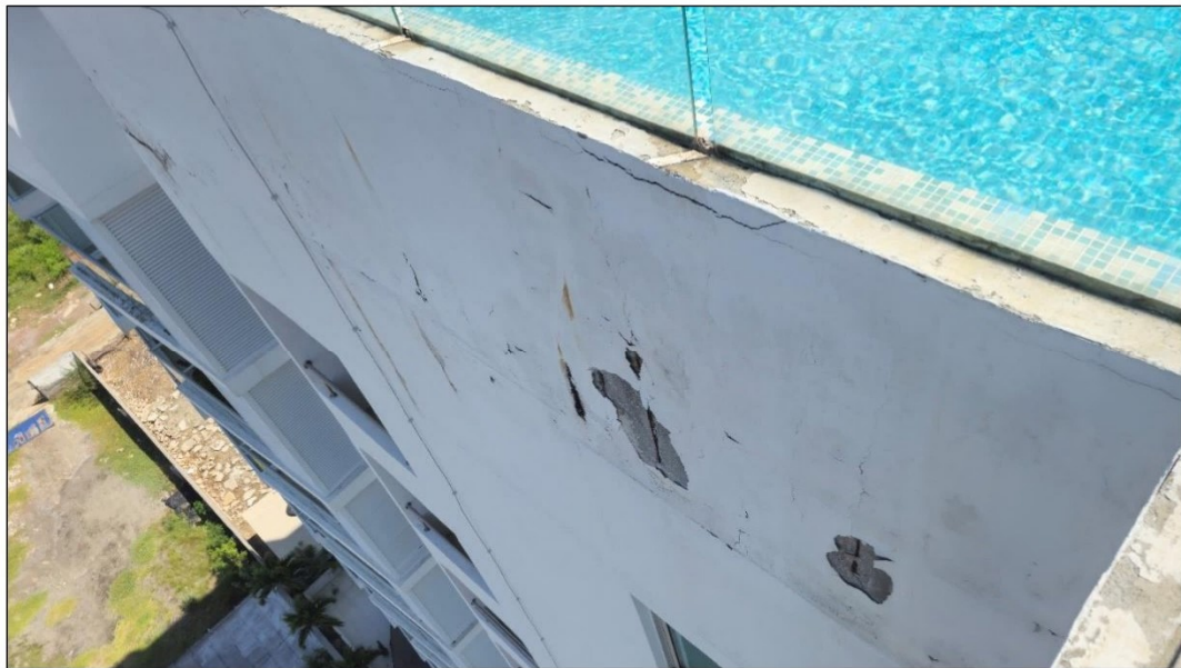
Foto 8. Corrosión del acero de refuerzo en muros estructurales en la zona de piscina, en la zona exterior del edificio al lado mar.
