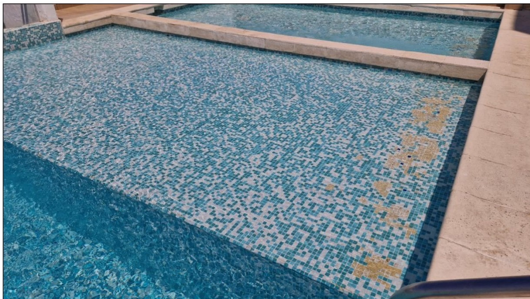
Foto 20. Pérdida del revestimiento en Cristanac de la piscina
