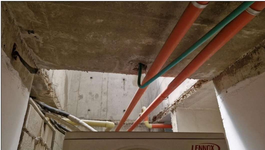
Foto 18. Mallas de acero expuestas. La losa de entrepiso al parecer fue cortada para abrir el ducto dejando a la vista el acero de refuerzo.
