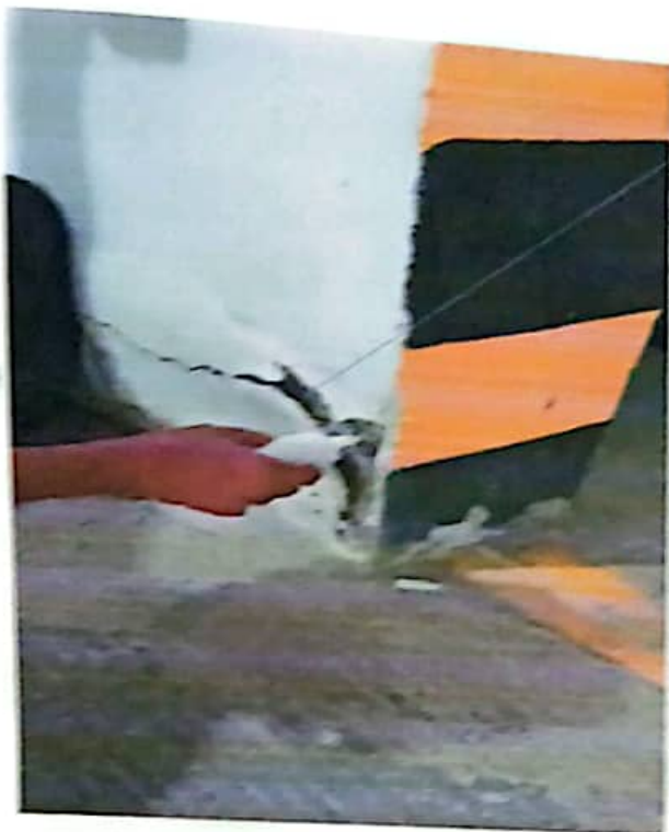
Foto 3: se puede apreciar concreto estallado, con alto grado de acidez lo cual compromete el acero de refuerzo del muro.
